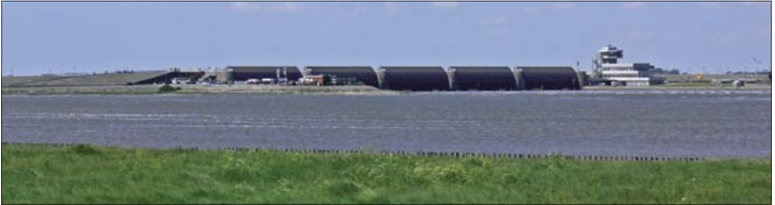
Das Eidersperrwerk bei Tönning.
