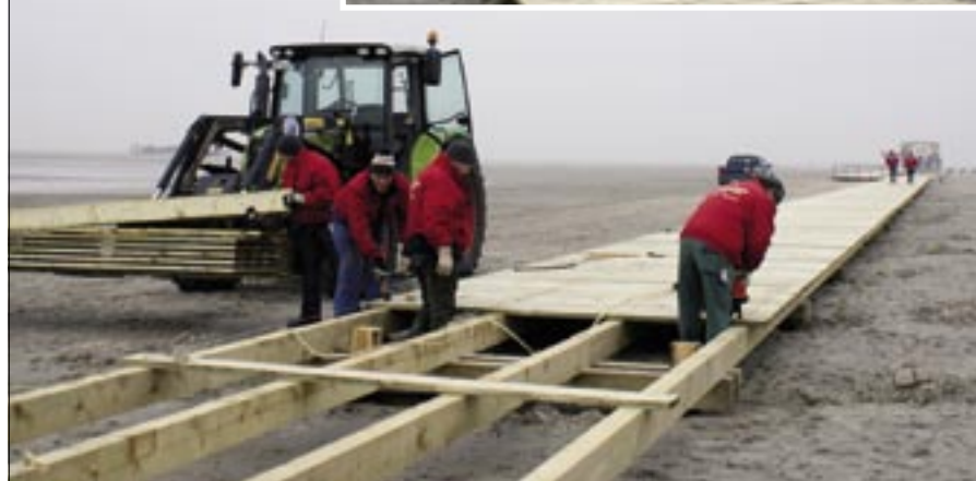
Ein neuer Fußgänger-Bohlenweg zum Ordinger Strand wurde gebaut.
